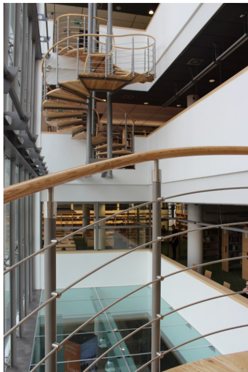
Fot. 1. Schody wewnętrzne w świetliku łączące piętra strefy wolnego dostępu. Źródło: Archiwum biblioteczne.
